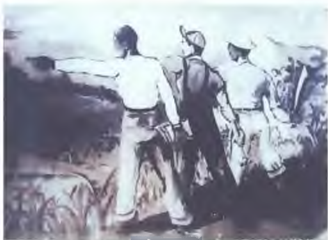
Mural, demolido. Levantamiento de cerro Tute de 1959. Ubicado en el comercio de D. Julio Herrera, avenida Central con calle tercera, Santiago de Veraguas.
