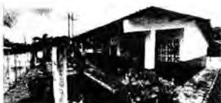
Edificio del C.E.B.G. Toza
