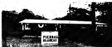
Edificio del C.E.B.G. Piedras Blancas
