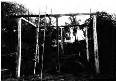
Levantamiento de los estacones esquineros y vigas para hacer el enjaulado de la casa
