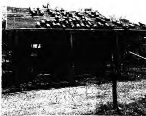
La casa embarrada, en fase de entejeado.
