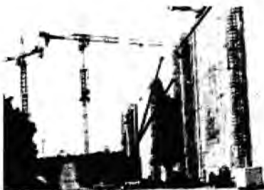
Trabajos de ampliación del Canal
