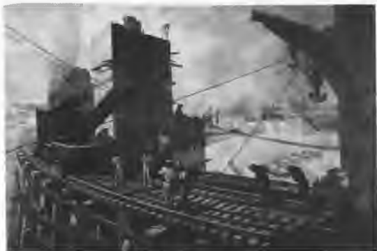
La construcción del vertedero de la Represa de Gatún
