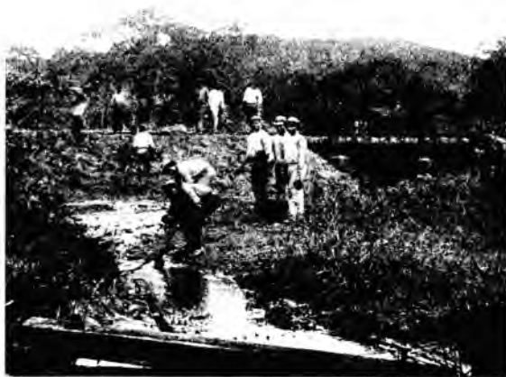
TRABAJADORES SANEANDO LOS CAMPOS DE LOS SITIOS DONDE ANIDAN LOS MOSQUITOS
