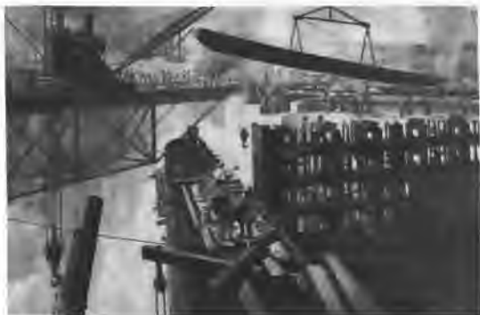
Construcción de una compuerta de esclusa
