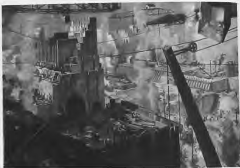
Construcción de las Esclusas de Miraflores
