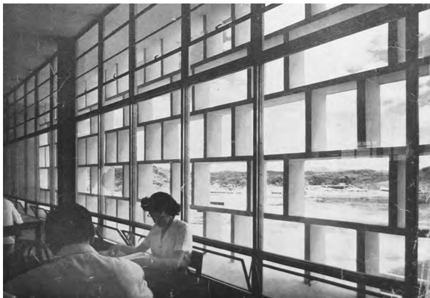
Un aula de la Ciudad Universitaria, con su quiebrasol de hormigón y ventanas de metal y vidrio (fuente: Architectural Forum , septiembre de 1951).
