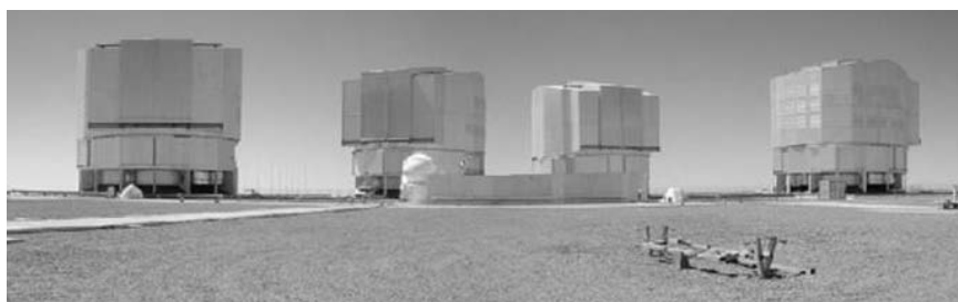
Fig. 3. El observatorio de Páranla. Es un observatorio astronómico situado en Cerro Paranal a 2.635 m de altitud y 120 kilómetros de sur de Antofagasta, Chile. Es operado por el European Southern Observatory. Posee cuatro telescopios separados de 8.2 m. que pueden combinarse para formar un quinto instrumento, el VLTI, el Very Large Telescope Interferometer.
