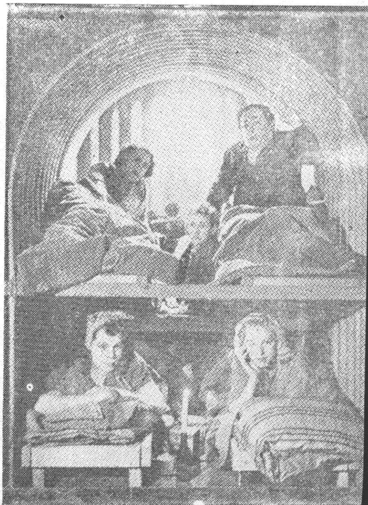
Para probar este refugio británico se la han dejado caer encima toneladas de ladrillo. Según los expertos, un refugio como éste o uno de tipo "Anderson", ab., cubierto de 90 cms. de tierra, protege las vidas aunque la explosión sea muy cercana.
