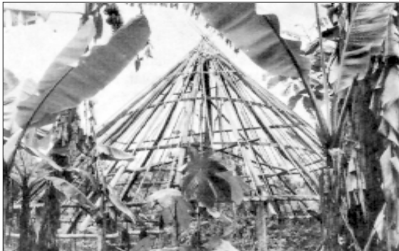
Casa de techo circular en proceso de construcción. Río Grande, Bocas del Toro.
