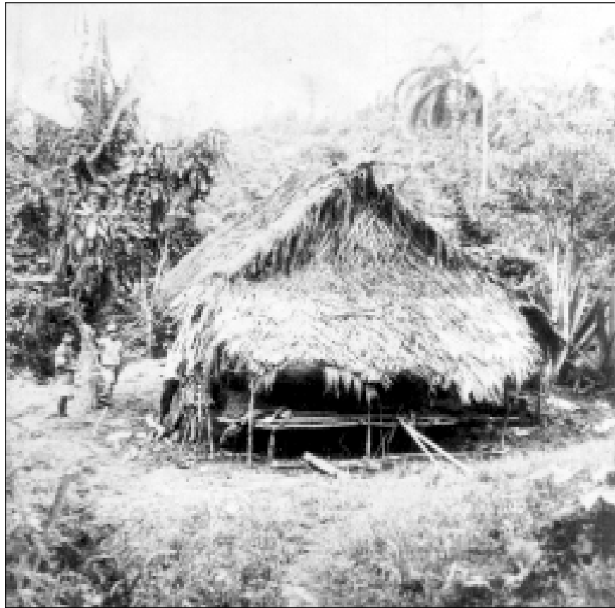
Vivienda Bokotá en Bocas del Toro.
