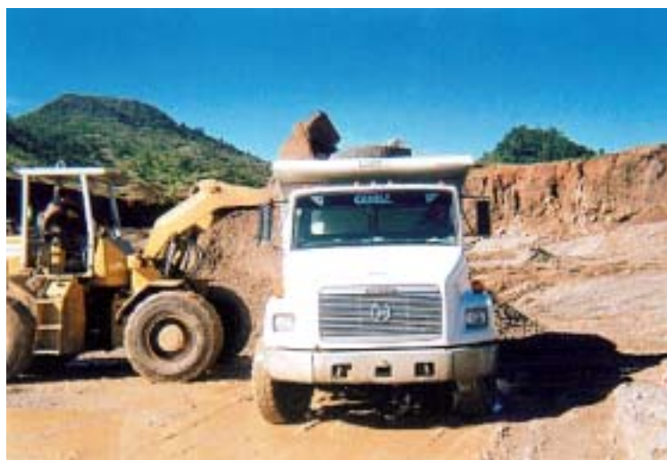
Cargador frontal cargando material en un camión
