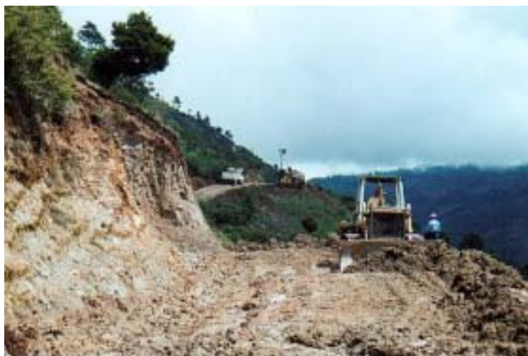
Trabajos de apertura de un camino rural en la Sierra de los Cuchumatanes
