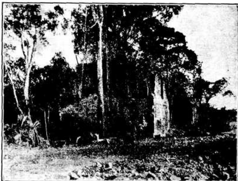
Vista exterior de la Iglesia de San José
