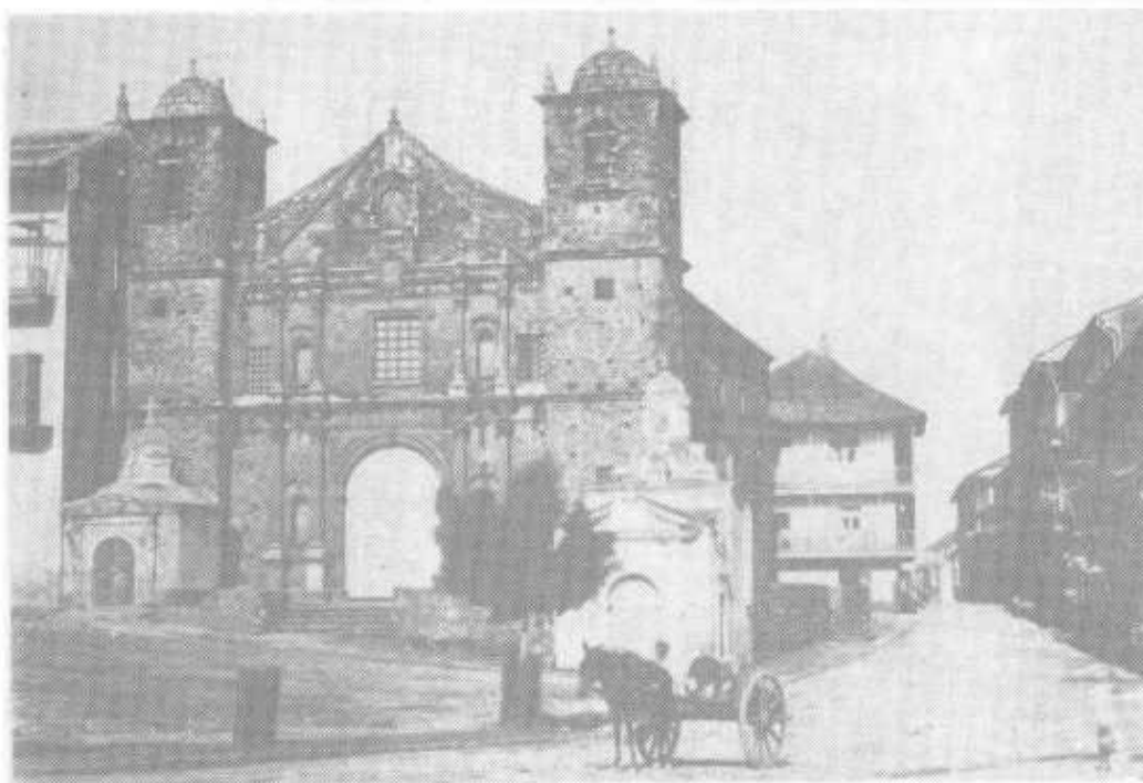
Escena del "intramuros" capitalino a fines de siglo XIX cuando Panamá era parte de Colombia. La Iglesia de la Merced y la entonces llamada "Carrera de Boyacá", hoy Avenida Central, la principal arteria comercial que conectaba a la Plaza de La Catedral, el barrio de clase alta, con la Plaza de Santa Ana, el corazón del arrabal popular. Foto: cortesía de la Comisión del Canal de Panamá.
