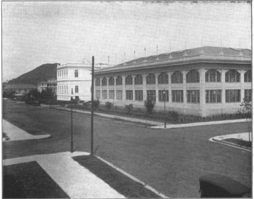
Vista al norte del Hospital
