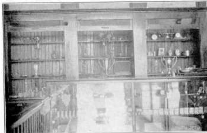
Vista Interior - Tienda en Panamá Interior View - Panama Store
