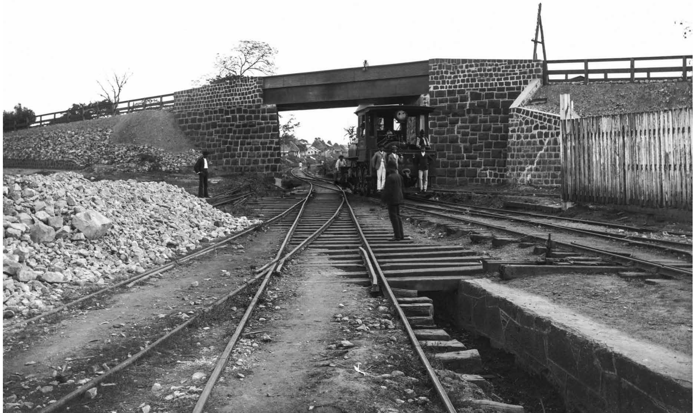
Fig. 30 Puente de Calidonia | Calidonia Bridge | Foto/Photo: Carlos Endara | Col. RLA/ASU
